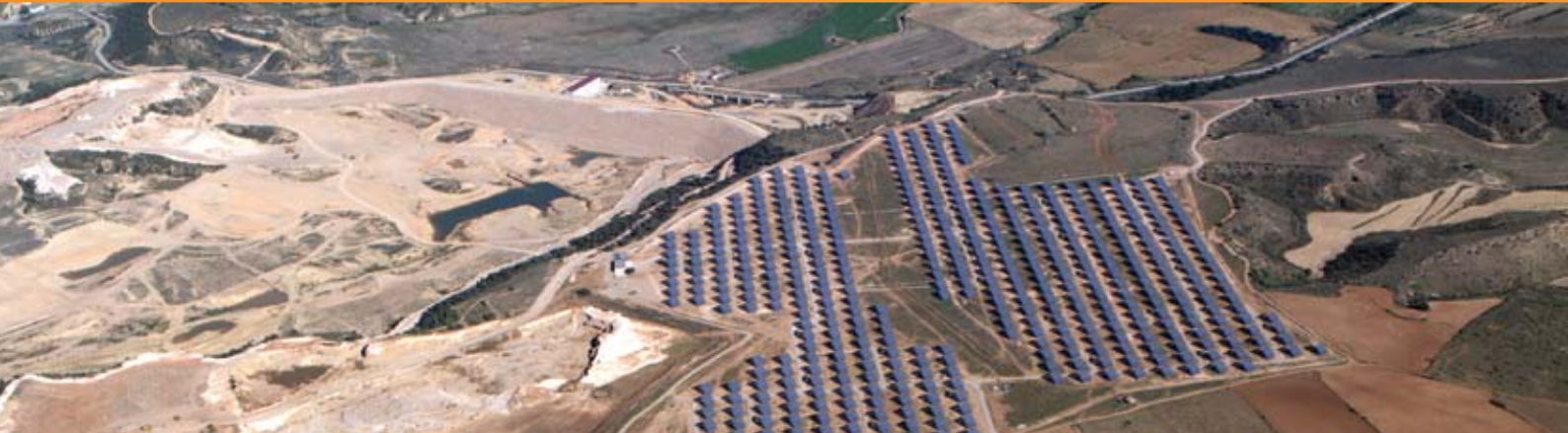
Parque solar Sarinena, courtesy: Suravia, fotografía aerea, Madrid
